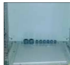
hátsó kábelvezető lap tömszelencékkel
