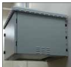
falraszerelés függőleges tartósínnal
